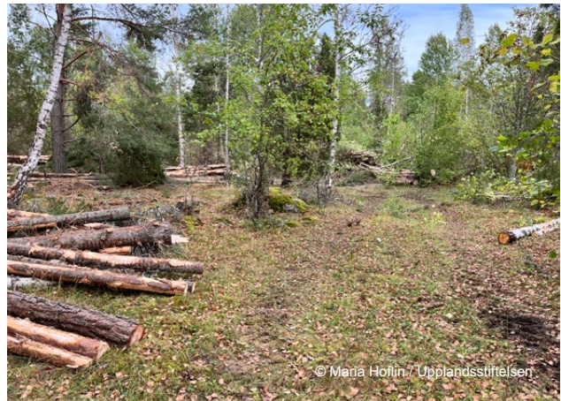
Pågående restaurering, röjning av igenväxande träd i hagmarkerna på Södergården.
