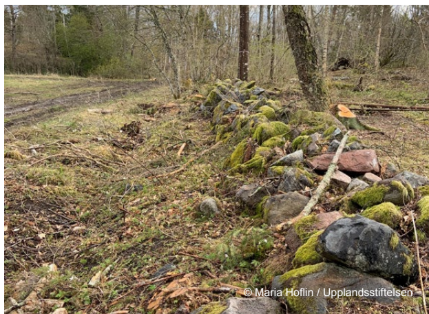
Framröjd stenmur efter åtgärd.
