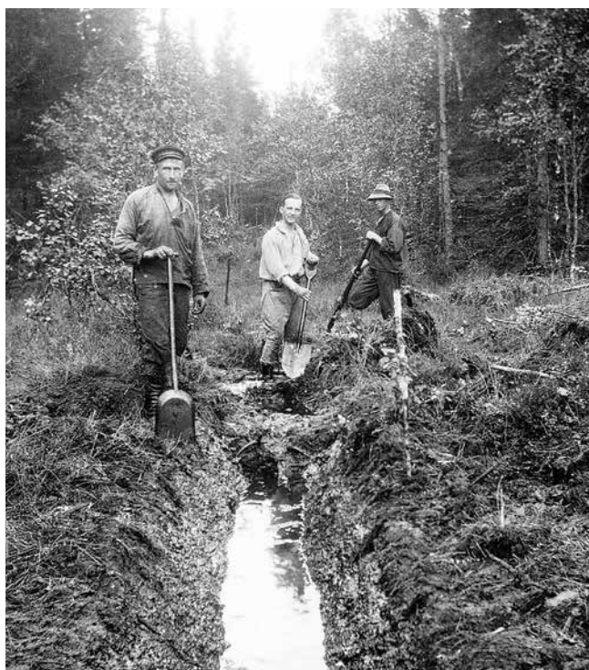
Dikning på en skogsmosse kring 1920. Många av dessa diken finns kvar och underhålls ännu i våra dagar. Foto: SLUs Mediabank
